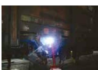
Поджатие дефектного места и проведение сварочных работ
