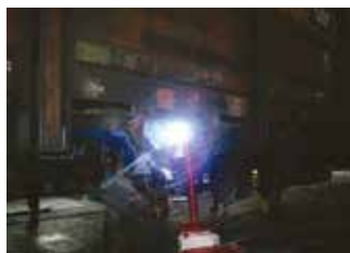
Поджатие дефектного места и проведение сварочных работ
