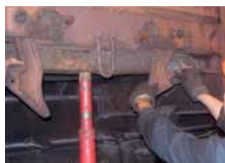
Поджатие люка и вставка уравнительных прокладок
